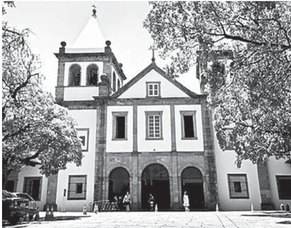
Mosteiro de São Bento (RJ)
